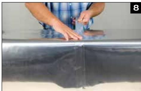
Zum Schluss mit Kaiflex ALU Tape die Längs- und Quernähte zusätzlich verkleben und sichern.
