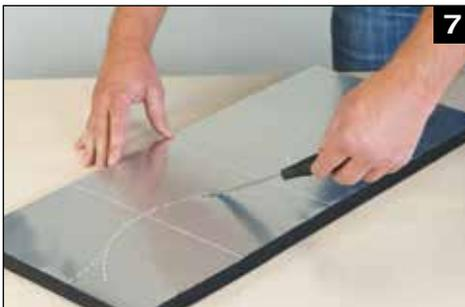
Beim Ausschneiden die lange Seite leicht anschrägen, um die Montage auf die Haube zu erleichtern. Zum Schluss die Längsnähte verkleben.
