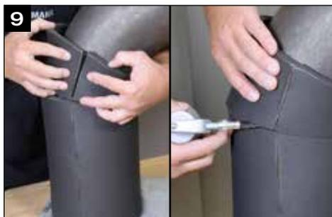
Spannungsfrei gedämmter Rohrbogen.
