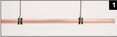
Schlauchisolierung montieren, auf Festigkeit der Schellen achten.
