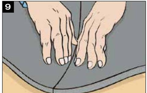
Zum Verteilen des Klebers auf große Flächen einen Spachtel oder eine Lammfell-Rolle benutzen. Auch hier sollte der Kleber sparsam aufgetragen werden. Nach ausreichender Abluftzeit kann das Plattenmaterial auf der zu isolierenden Fläche aufgebracht werden.
