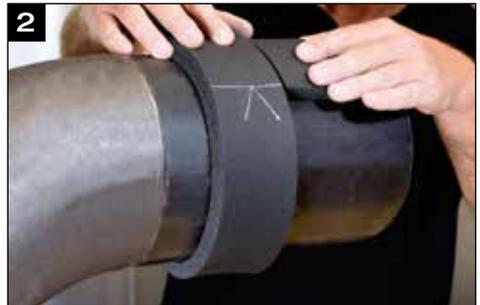
Der Bogen mittels Aufzeichnung abgewickeln. Dabei zu-erst den Bogenradius aufzeichnen und durch die entsprechenden Bogenteile aufteilen. Mittig der Durchmesser des gedämmten Bogens aufzeichnen und in sechs gleiche Teile einteilen.
