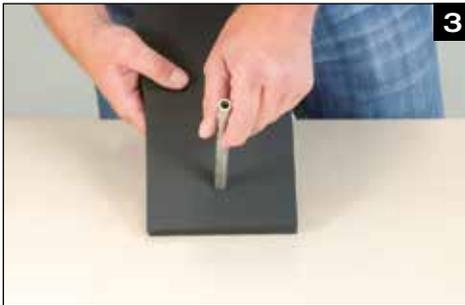
Dämmstreifen zuschneiden: Länge entspricht Umfang des Isolierschlauches + mindestens Dämmschichtstärke. Ausschnitt für Aufhängung (Stockschraube) fertigen (stanzen).
