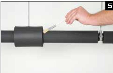
Im Anschluss beide Seiten der Überlappung ebenfalls mit Kaiflex Spezialkleber versehen.
