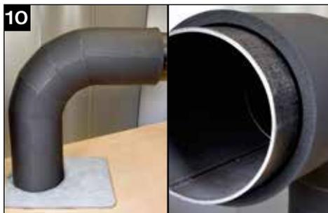
Sofern aufgrund der gewählten Gesamt-Dämschichtdicke (gemäß Tabelle „Verarbeitung von Plattenmaterial“) eine zweite Lage benötigt wird, Schritte 2 bis 9 wiederholen..
