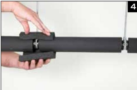
Dämmstreifen montieren und Längsnaht, wie vertikalen Einschnitt für Schellenbefestigung (Stockschraube), mit Kaiflex Spezialkleber verkleben.
