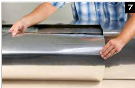
Die Kaiflex Platte um den Luftkanal legen und die beiden äußeren Enden aneinanderkleben.
