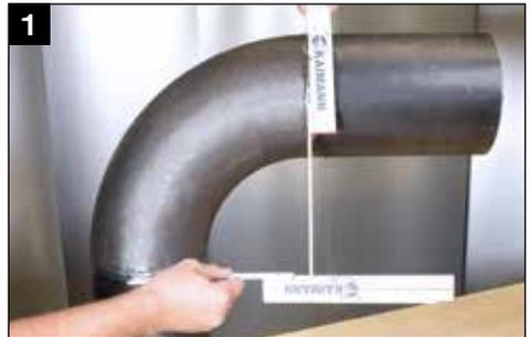
Der exakte Umfang mit einem Streifen des entsprechenden Kaiflex Materials ermitteln. Um unnötige Spannungen zu vermeiden, den ermittelten Umfang um 10 mm, bei Zuschnitten über 3.000 mm Länge um 20 mm, verlängern.
