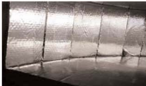
Hagyományos módszerrel hajlított könyök idom belseje (nagyobb nyomáskereső).
